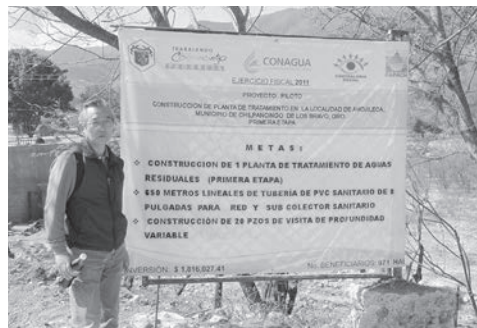
地方自治体に設置された小規模プラント施工掲示と筆者
