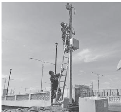
本件のために立てた電柱に警報器具を据え付ける作業
